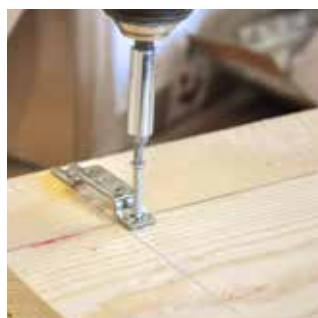
Przykręcenie strzemiączka KOMBI do elementu
