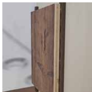
Zawieszenie gotowego elementu bezpośrednio na szynie
